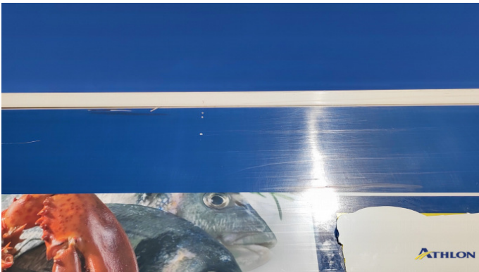
13. parete laterale - posteriore - destra Graffio/Rigature
