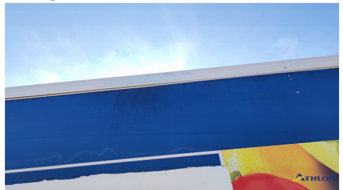
14. telaio del tetto - sinistro Graffio/Rigature
