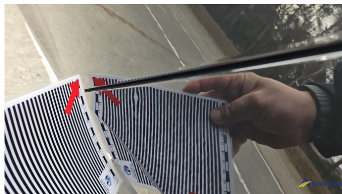
7. Seitenwand - Hinten - Links 1 Delle
