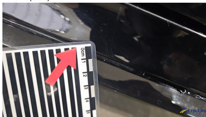
8. Schweller - Links Kratzer
