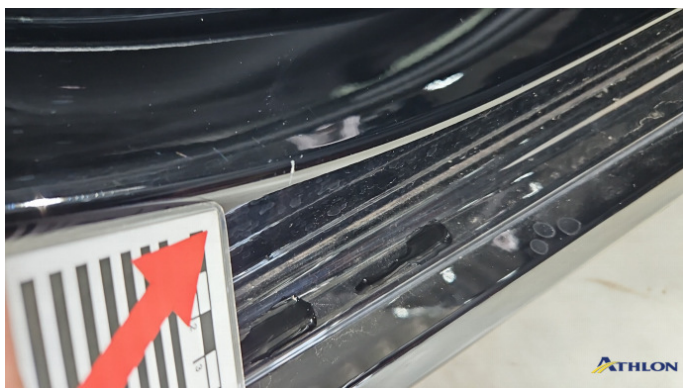
7. Türeinstieg Hinten - Rechts Kratzer
